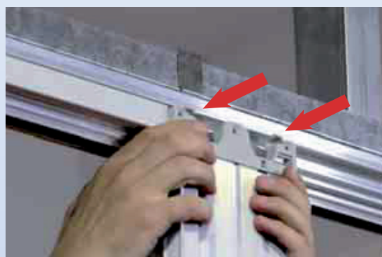
17: Blijf de plastic bovenprofielen in de rail duwen tot er een klik te horen is.
