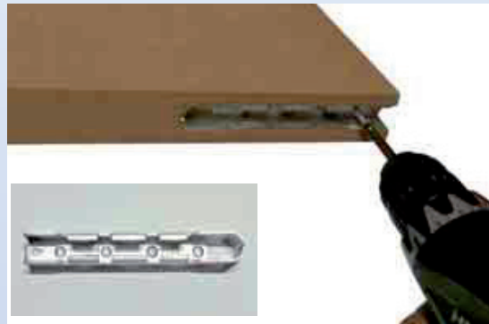
32: Bevestigings profiel in de deur bevestigen.
