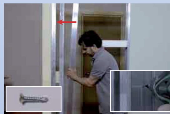
24: Monteer het profiel t.b.v. de stootlijst.
