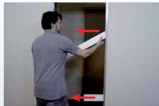
22: Voor het plaatsen van de gipsplaten zorg dat de wand stabiel genoeg is, na het plaatsen van de gipsplaten de afstandhouders verwijderen deze zitten niet in het assortiment.
