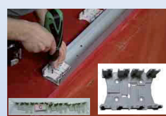
14: Plastic voeten bevestigen in het onderprofiel van de metal stud wand.
