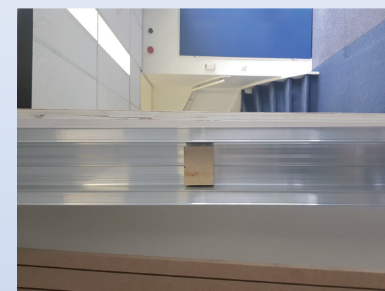
26: De afstandhouders in het profiel bevestigen.
