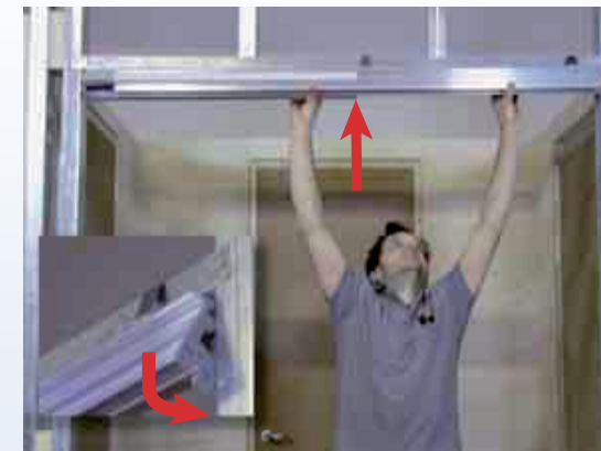
10: Rail bevestigen aan de bestaande constructie.
