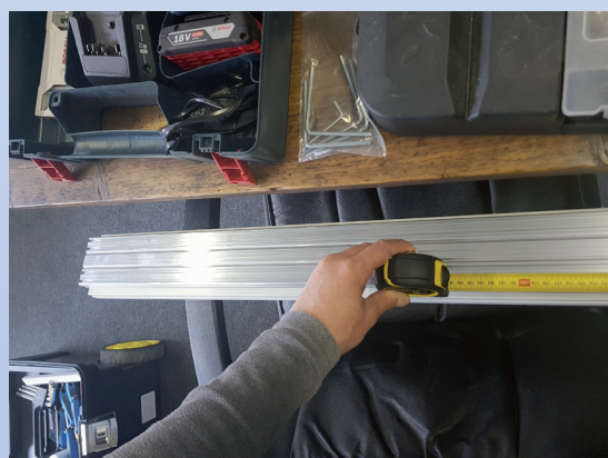
3: Rail op de juiste lengte afmeten.
